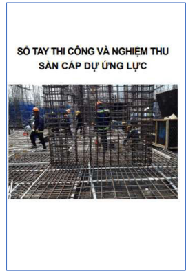
Cung cấp sổ tay thi công & nghiệm thu
