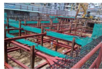
BIỆN PHÁP THI CÔNG ĐÀO MỞ
